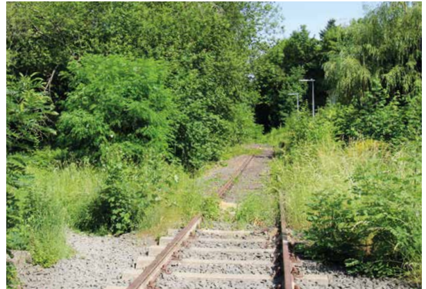
Die Aartalbahn hat noch Potenzial ...
