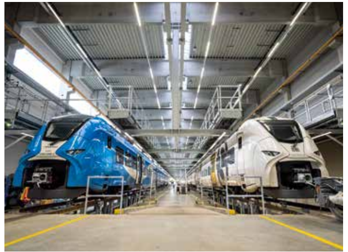
Das Werk von EUCO Rail in Langweid bietet zahlreiche Gleise in drei Hallen, darunter auch aufgeständerte und Grubengleise. EUCO Rail-Techniker analysieren Betriebsdaten direkt im Fahrzeug und planen Wartungen digital voraus.
